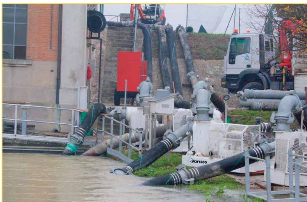
Drenaggio di zona allagata Drainage of flooded area Drenaje de lugar inundado
